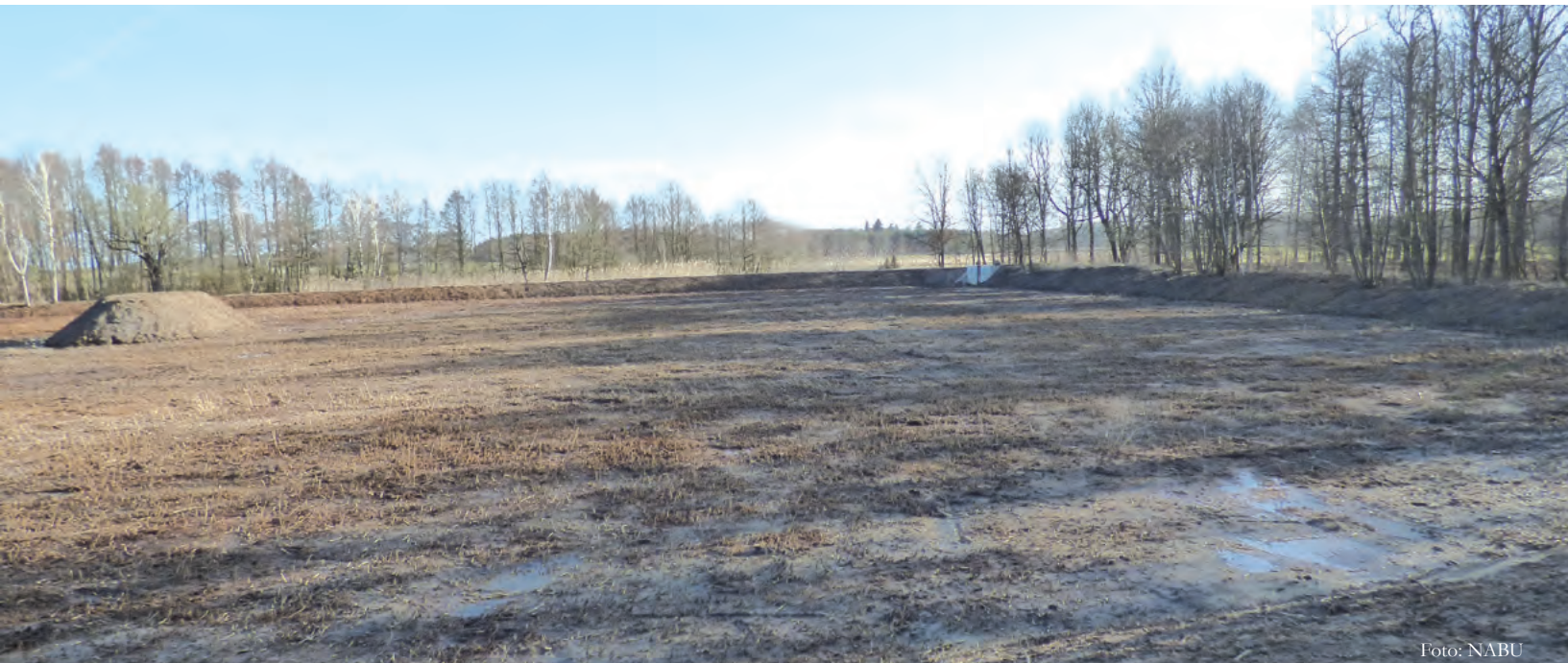
rechts oben: Marodes Bauwerk vor der Sanierung rechts Mitte: Herstellung von Überlaufschwellen rechts unten: Sanierung und Neubau von Regulierungsbauwerken unten: Sohlberäumung zur Sicherung einer langfristigen Wasserhaltung
